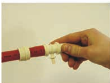
4. Az idomot betoljuk a feltágított csőbe ütközésig.
