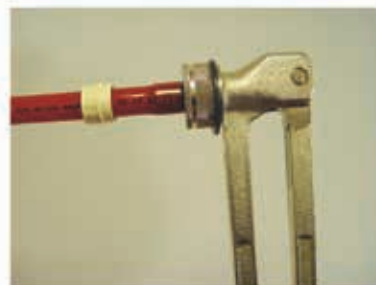
3. A csövet feltágítjuk többszöri tágitás-forgatással
