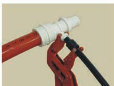
5. Felhelyezzük a megfelelő méretű prészszerzőt.
